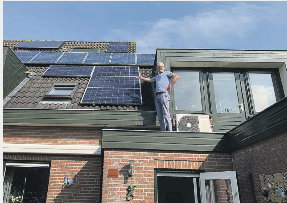
Zonnepanelen op het dak bij inwoner Ad van Rooijen
